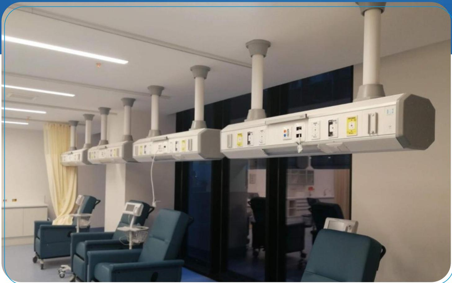
Mantiene el equipamiento lejos del piso que, en combinación con cables y mangueras de conexión cortos, garantizan máxima higiene y un área de trabajo despejada.
